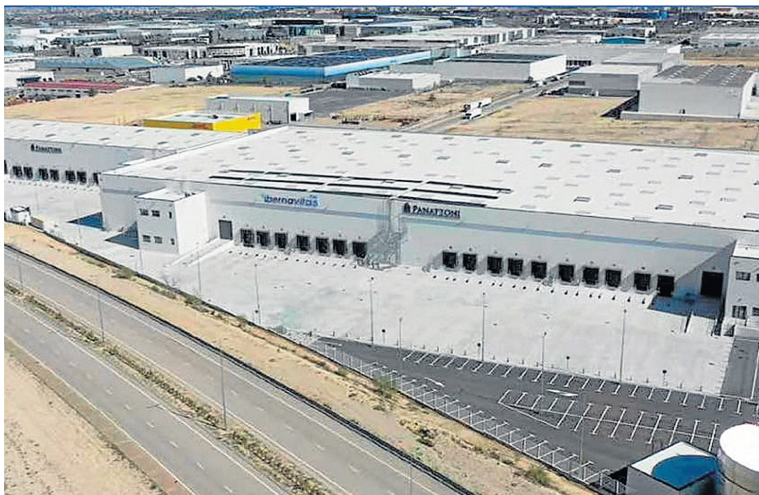
Esta es la nave que ocupará el proyecto de TDG Ibernnavitas en Plaza. L. R.
