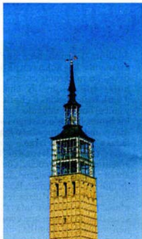
Torre de la Cámara de Comercio.
