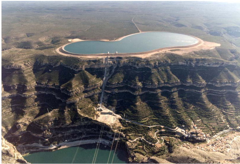
Central de bombeo de La Muela (Júcar)
