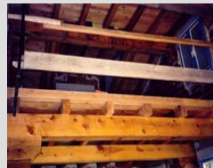
VIGAS Y FORJADOS DE MADERA ASERRADA
