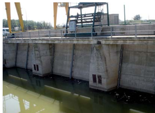
Figura 3.27. Presa de central hidroeléctrica en el río Ebro
