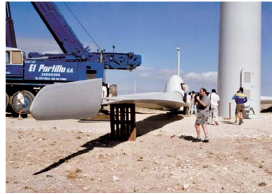
Figura 9.3. Montaje de un aerogenerador
