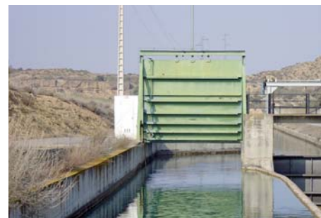
Figura 9.9. Canal de derivación de una minicentral hidroeléctrica
