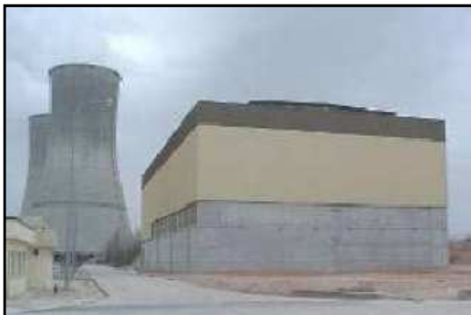
Edificio exterior del ATI de Trillo
