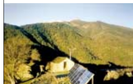
Combinación de energías renovables.
