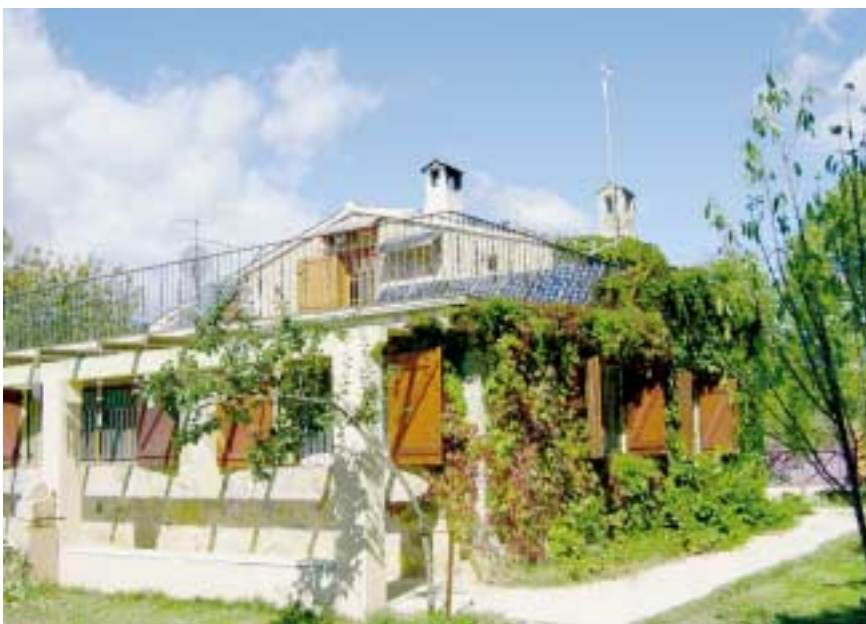
Detalle del porche y la cubierta vegetal.
