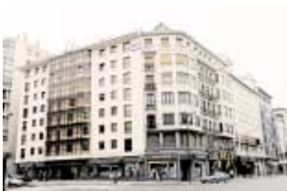
Sede central de DKV Seguros en Zaragoza.
