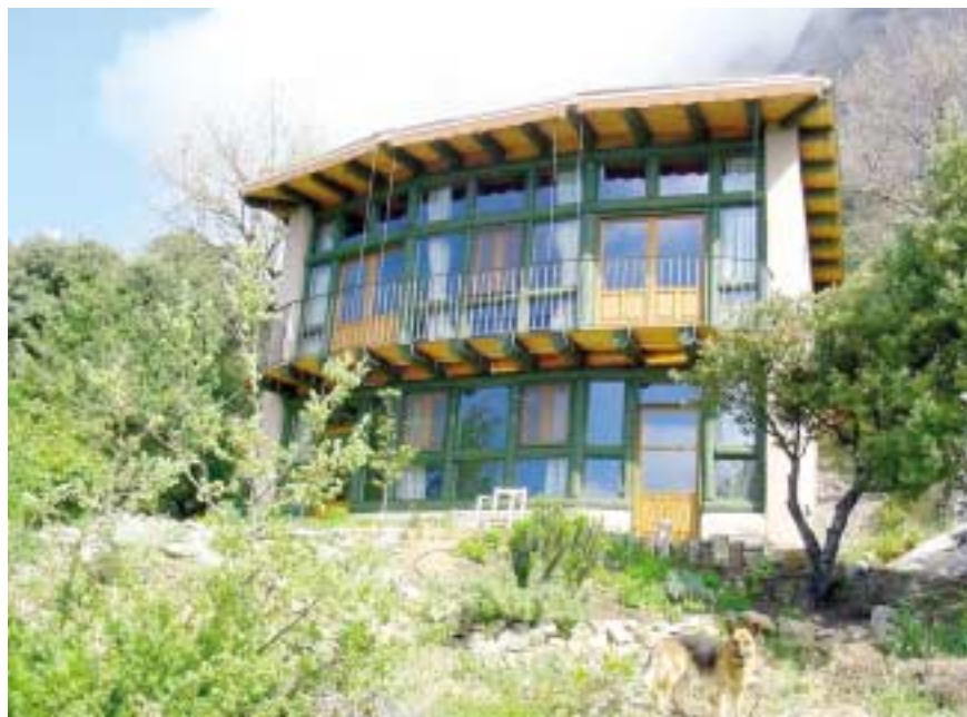
Grandes ventanales con toldo en la cara sur de la vivienda.
