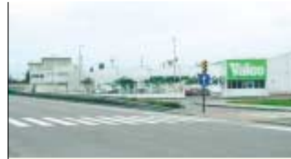
Planta de Valeo Térmico Motor en Zaragoza.
