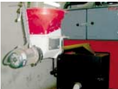
Detalle de la tolva de alimentación
