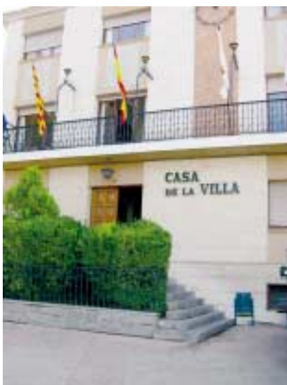
Fachada del Ayuntamiento de Andorra.
