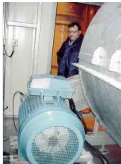
Operaciones de mantenimiento en los sistemas de climatización.
